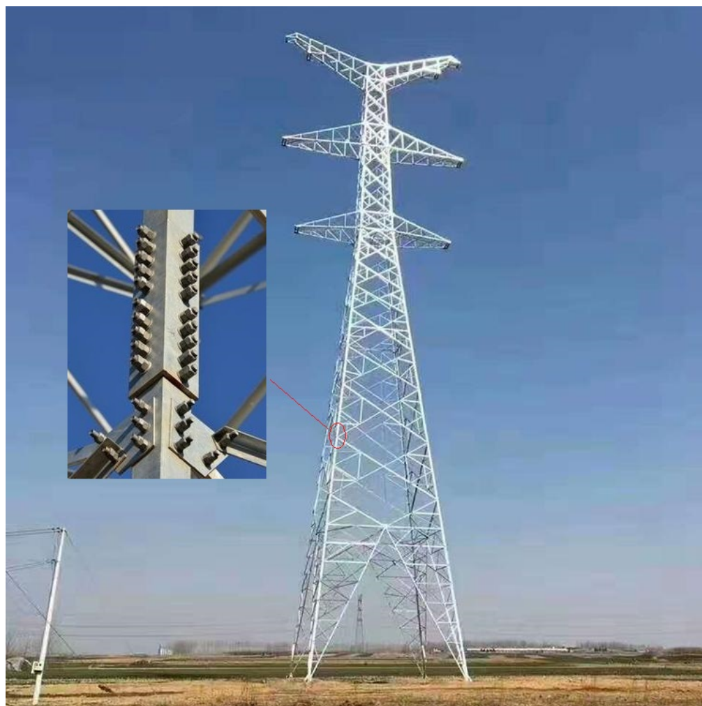
铁塔紧固件安装示意图
